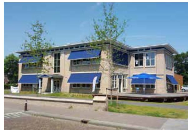
wijkcentrum Schadewijk heeft belangrijke functie in de wijk
