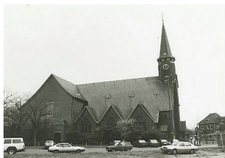
(Na de verbouwing)
